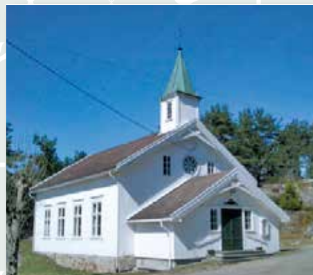
Justøy kapell Brekkestøveien, 4780 Brekkestø
